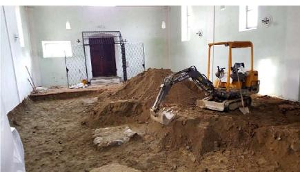
konnten nur mehr als abgebrochene Stücke entnommen werden. Der Grund für diesen Faulprozess ist die enorme Bodenfeuchtigkeit. Hauptgrund war aber die Verlegung der Balken und Bretter direkt auf dem Erdreich ohne Zwischenraum und Luftzirkulation.
